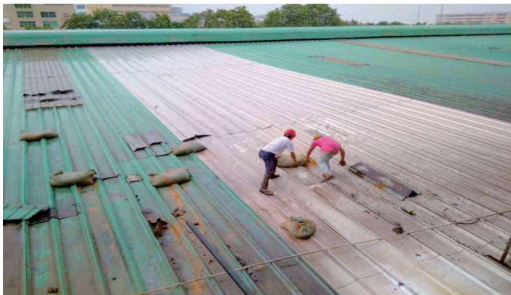
仓库房顶加重
